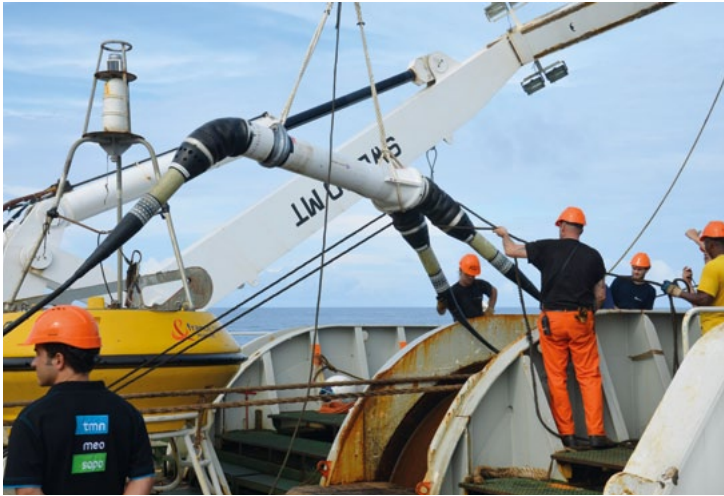
Lançamento de uma unidade de derivação (2011). Branching unit deployment (2011).
