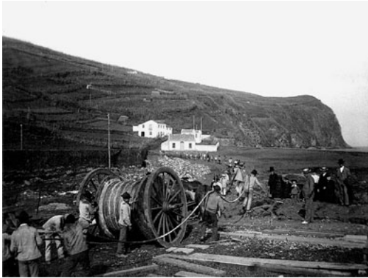
Amarração de um cabo submarino da Deutsche Atlantische Telegraphengesellschaft (DAT), Horta, Faial – Açores, Associação dos Antigos Alunos do Liceu da Horta (1904). Landing of a Deutsche Atlantische Telegraphengesellschaft (DAT) submarine cable, Horta, Faial – Azores, Associação dos Antigos Alunos do Liceu da Horta (1904).
