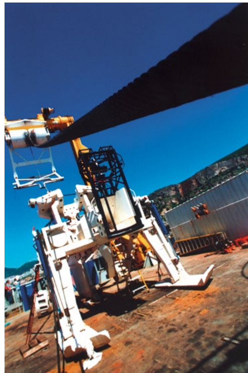
Charrua para enterramento do cabo submarino. Sea plough for submarine cable burial.
